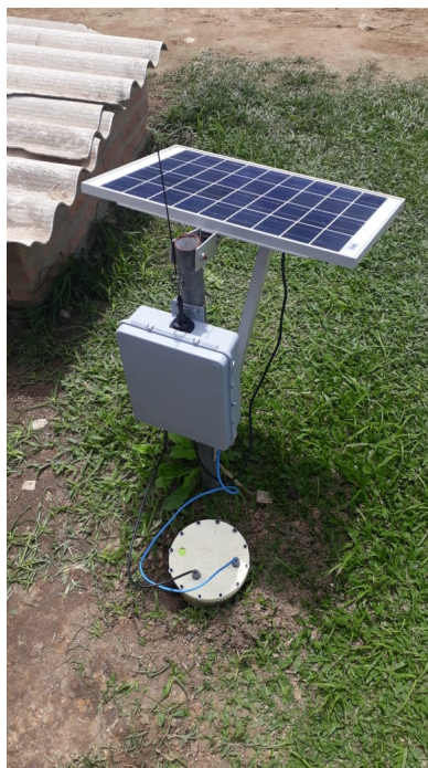
Figura 30 – Dispositivo de monitoramento microssísmico fixado ao solo para a realização dos testes de aceitação
