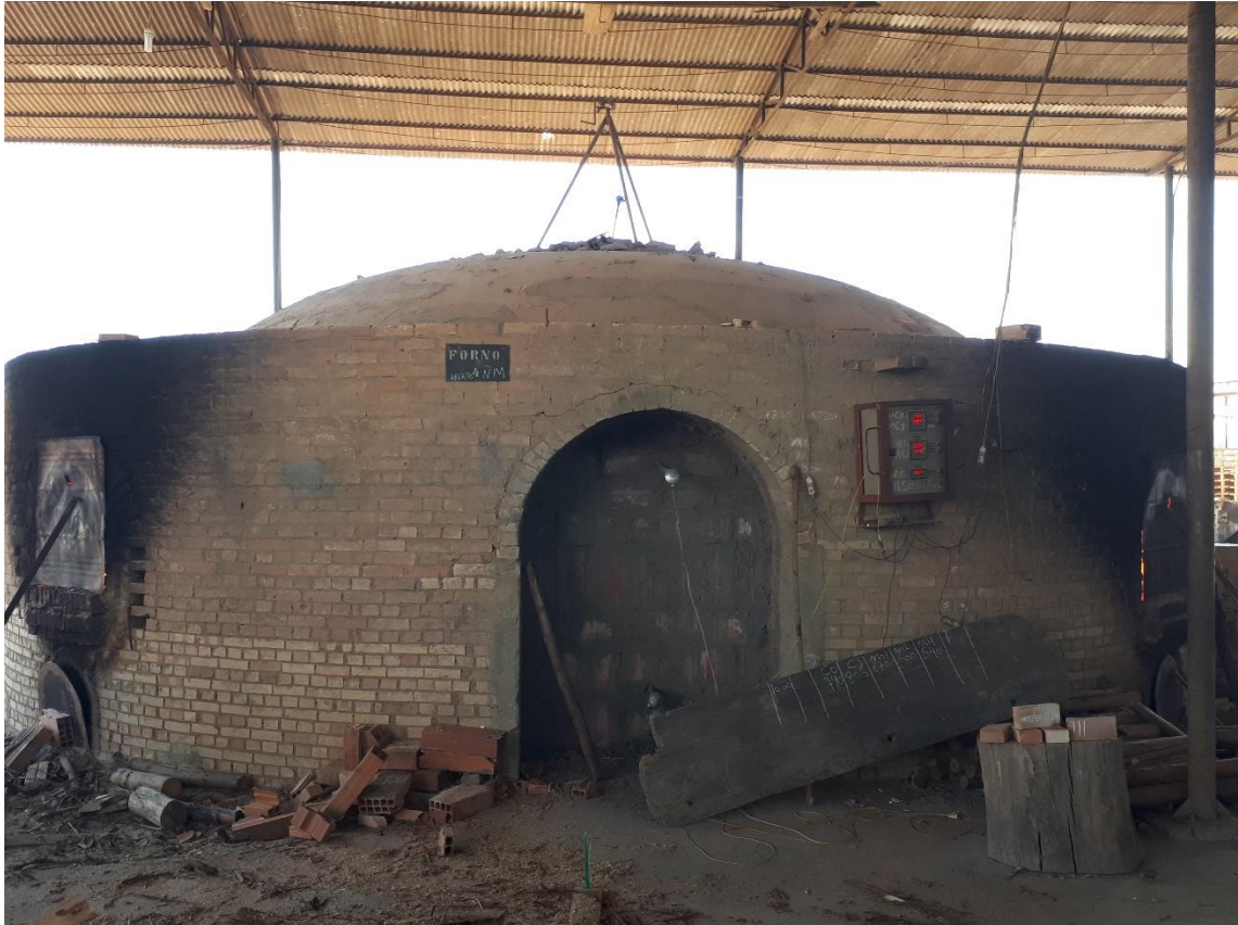
Figura 22- Forno Intermitente Cerâmica Vermelha Fonte: Autor (2018)
