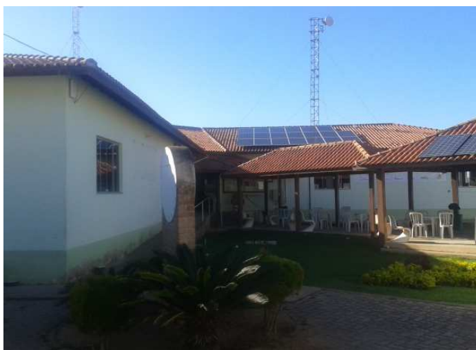
Figura 8. Painéis fotovoltaicos - Polo de Inovação. O Autor (2017).
