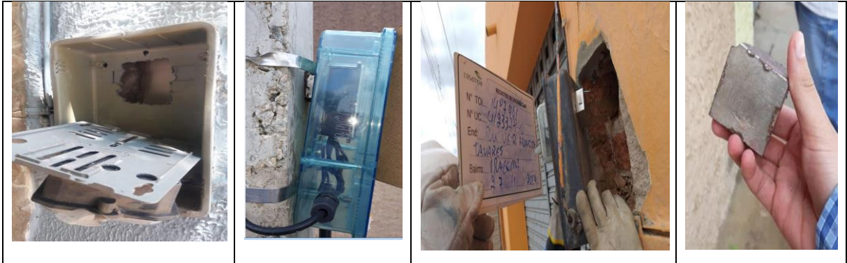
Figura 13: Exemplos de fraudes com utilização de ímã
