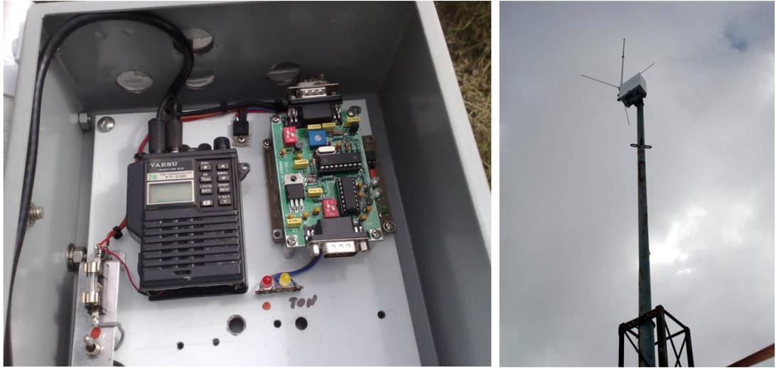
**Figura 10:** Equipamentos e armário instalados em uma torre
