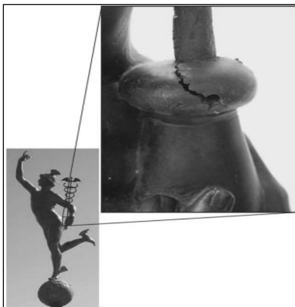
Figura 11. Corrosão sob tensão causada em um monumento de bronze por acúmulo de ferrugem em torno de uma barra de ferro.
