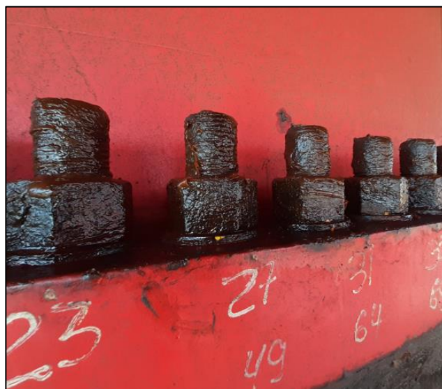
Figura 16. Protetor temporário aplicado em parafusos tipo estojo.
