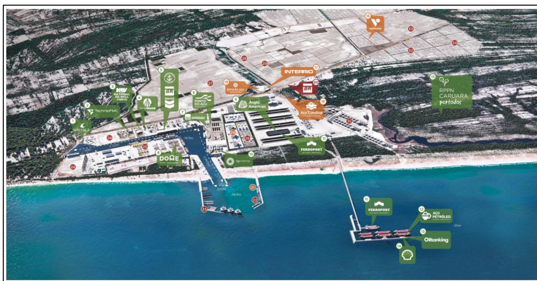
Figura 3. Imagem aérea do Complexo do Porto do Açú.
