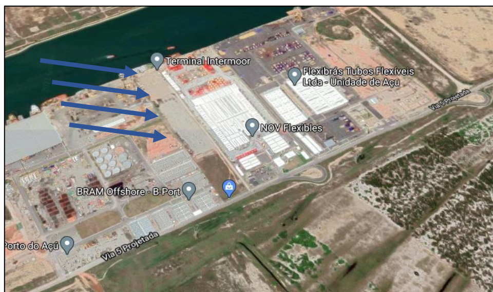
Figura 26. Vista aérea com representação dos ventos incidindo nas indústrias do CPA.
