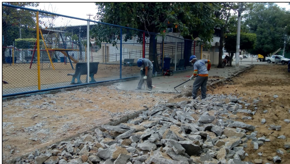
Figura 3: Obra de reforma no centro da cidade gerando RCC.
