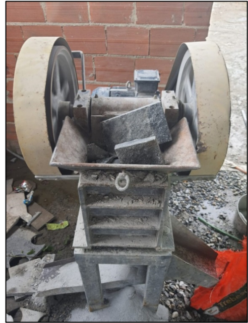
Figura 20 - Britagem dos resíduos Fonte: Autores
