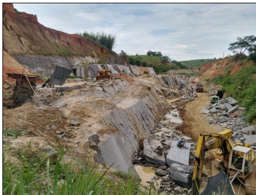
Figura 7: Redução da rocha sã em maciços Fonte: Autores
