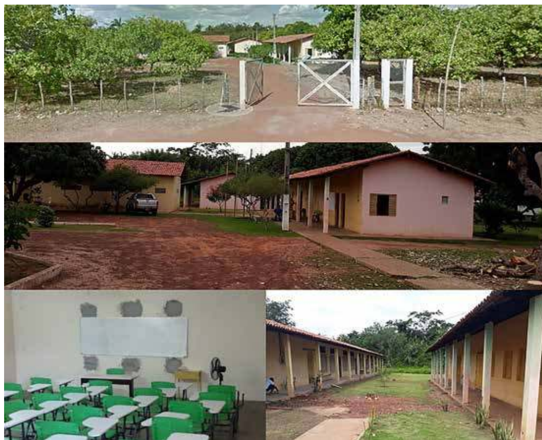
Figura 1. Entrada da escola, Setores administrativos e Bloco das salas de aula
