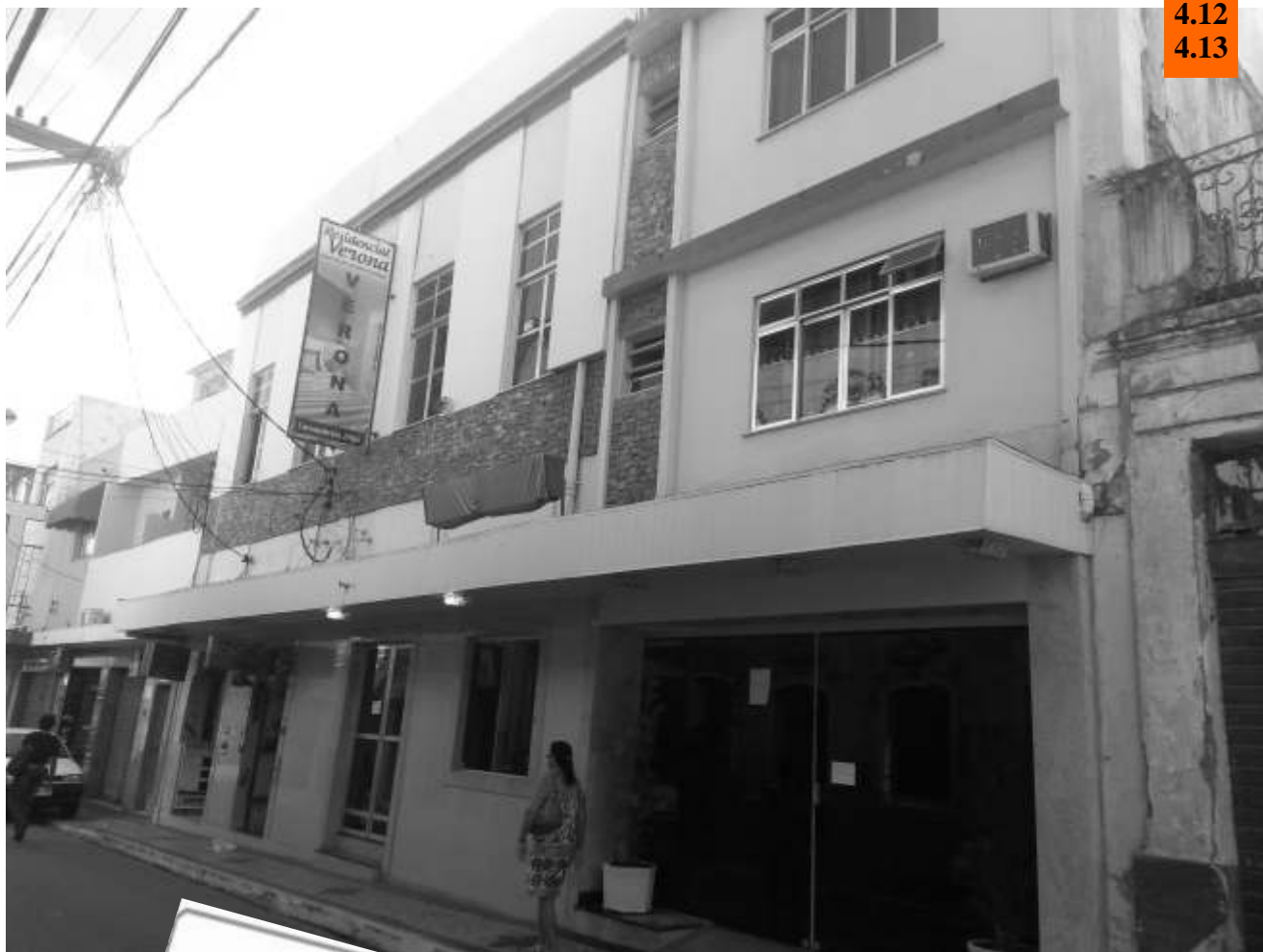
Fachada imóvel. Fonte: Autoria própria(2014)
