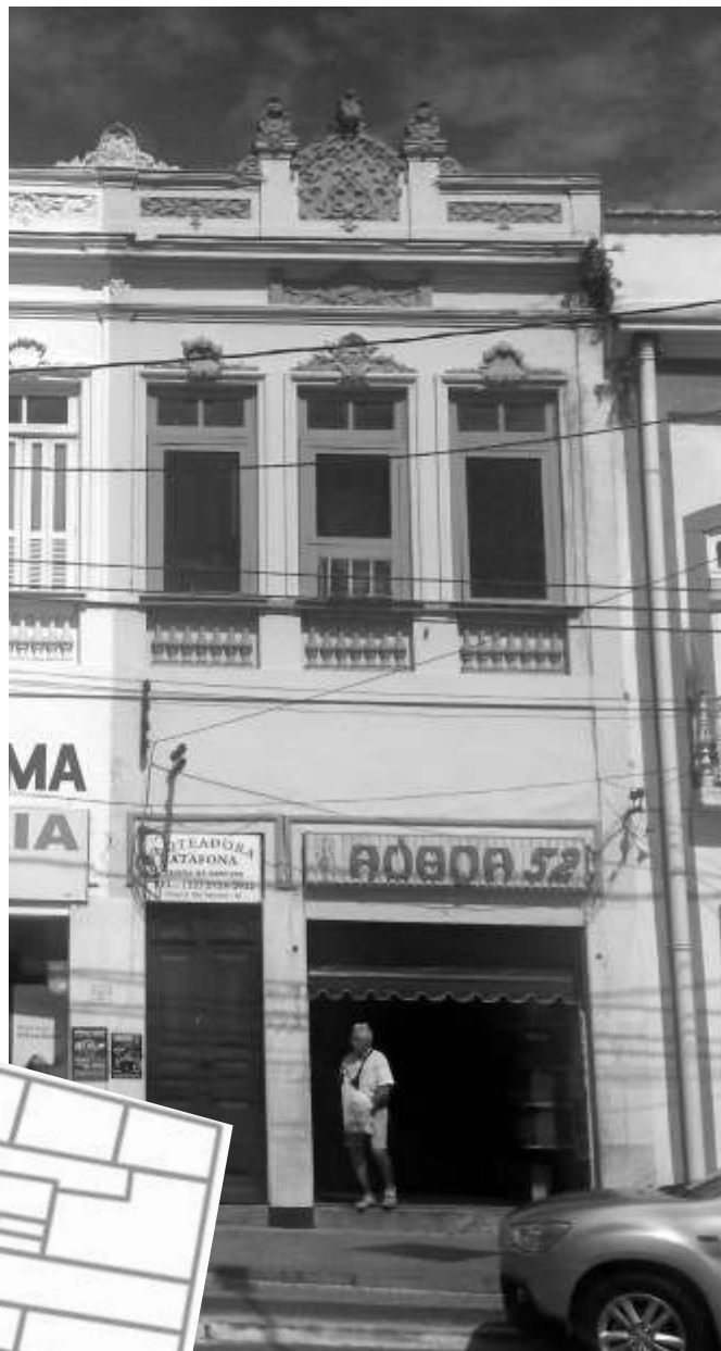
Fachada imóvel. Fonte: Autoria própria(2014)
