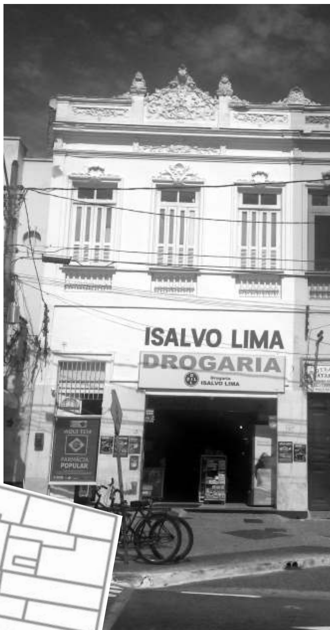
Fachada imóvel. Fonte: Autoria própria(2014)
