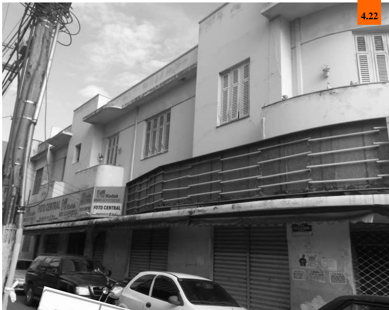
Fachada imóvel. Fonte: Autoria própria(2014)
