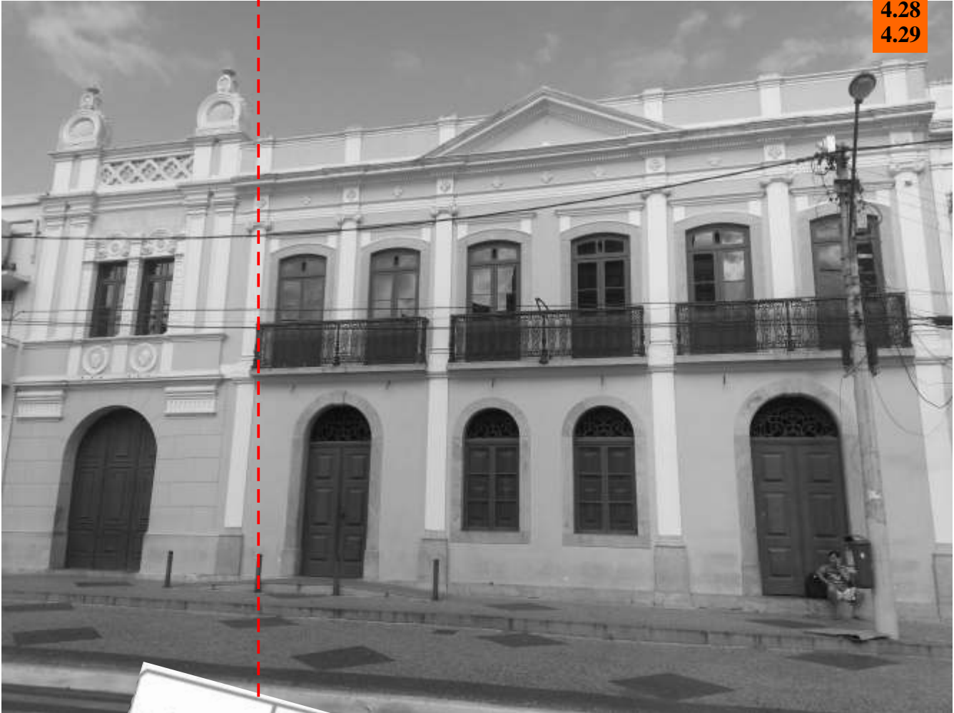
Fachada imóvel. Fonte: Autoria própria(2014)
