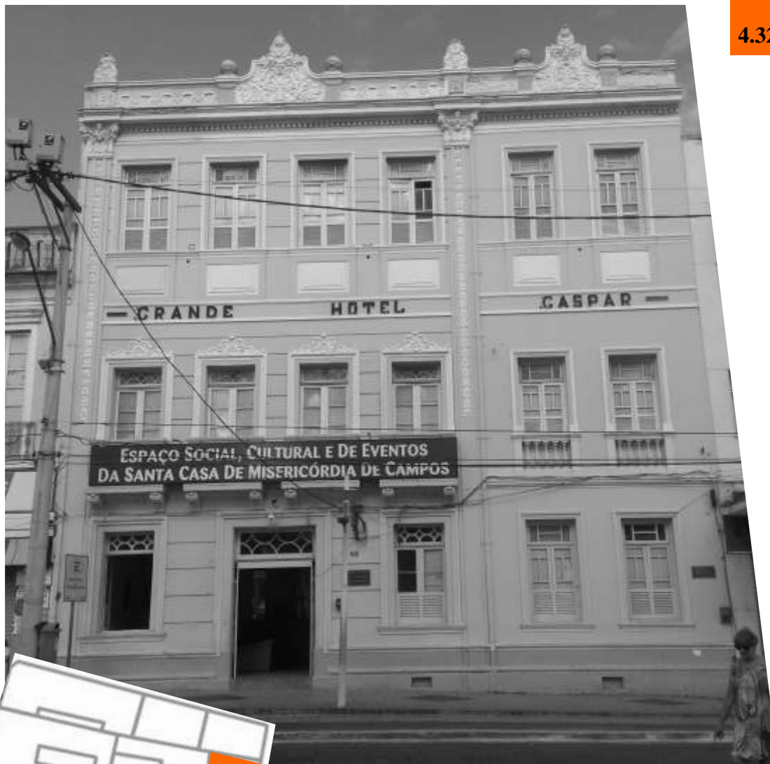
Fachada imóvel. Fonte: Autoria própria(2014)
