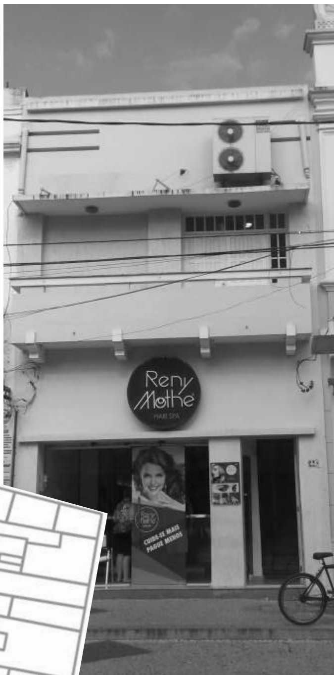
Fachada imóvel. Fonte: Autoria própria(2014)
