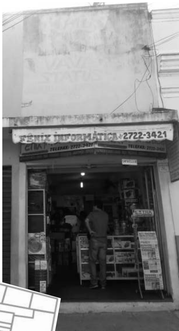
Fachada imóvel. Fonte: Autoria própria(2014)
