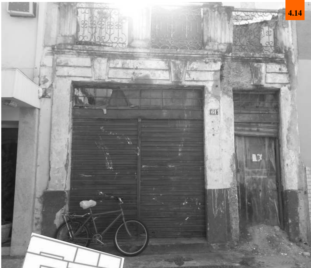
Fachada imóvel. Fonte: Autoria própria(2014)
