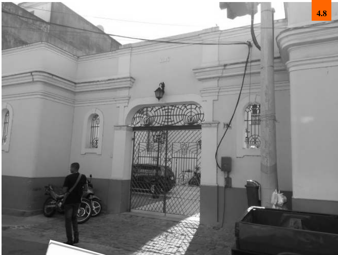
Fachada imóvel. Fonte: Autoria própria(2014)
