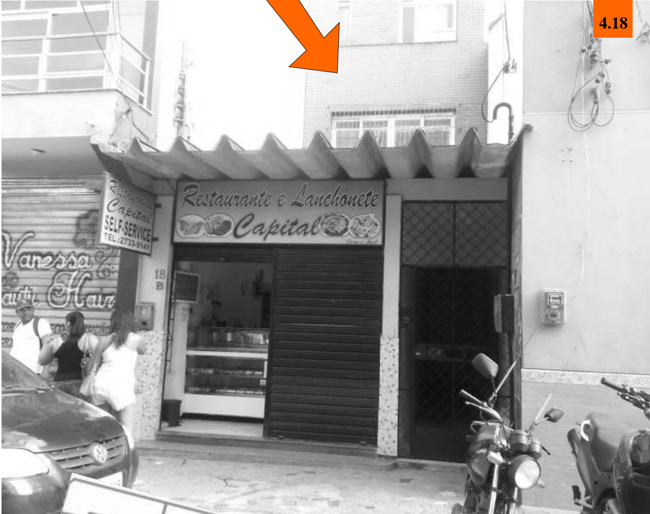
Fachada imóvel. Fonte: Autoria própria(2014)
