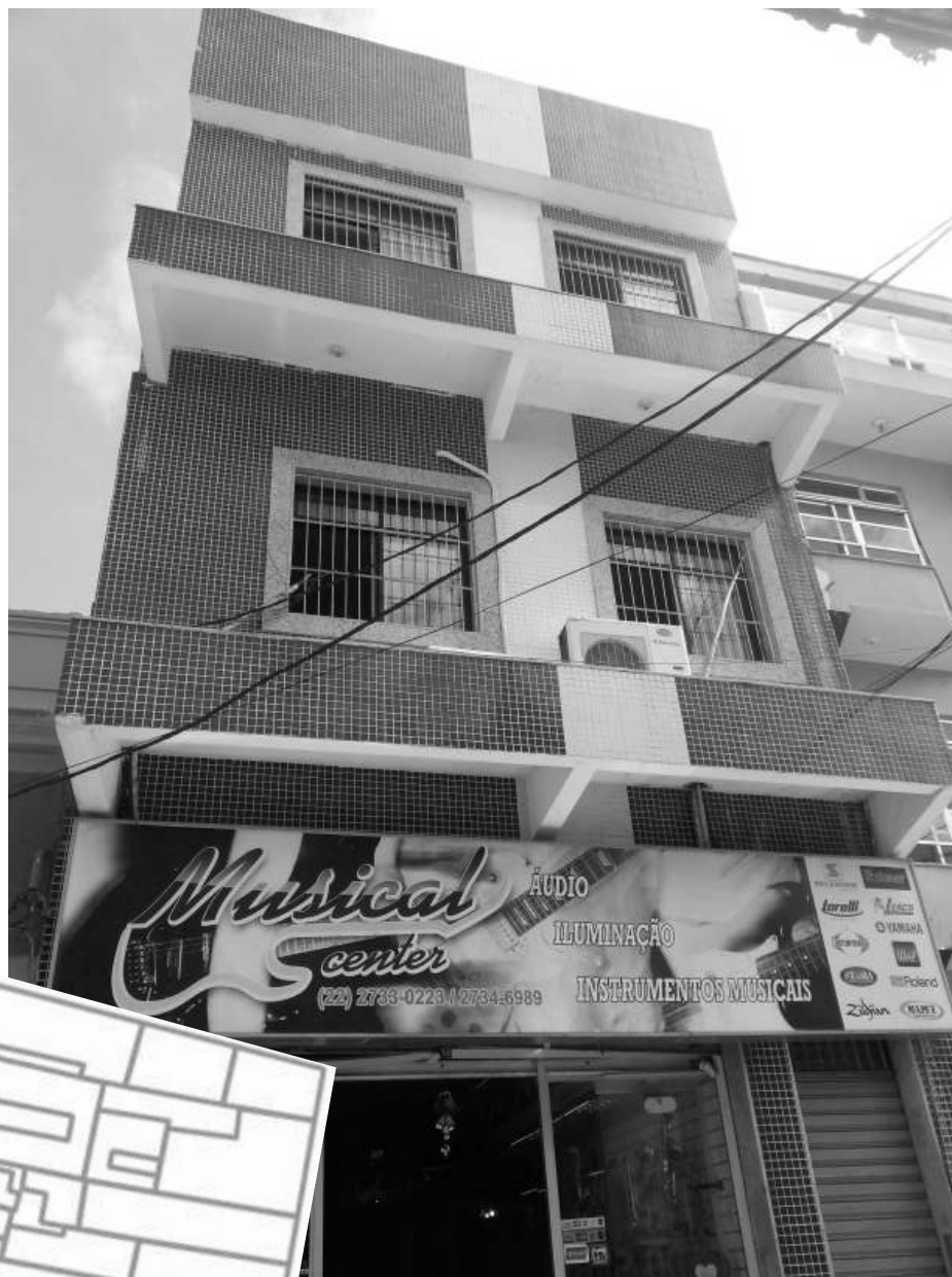
Fachada imóvel. Fonte: Autoria própria(2014)
