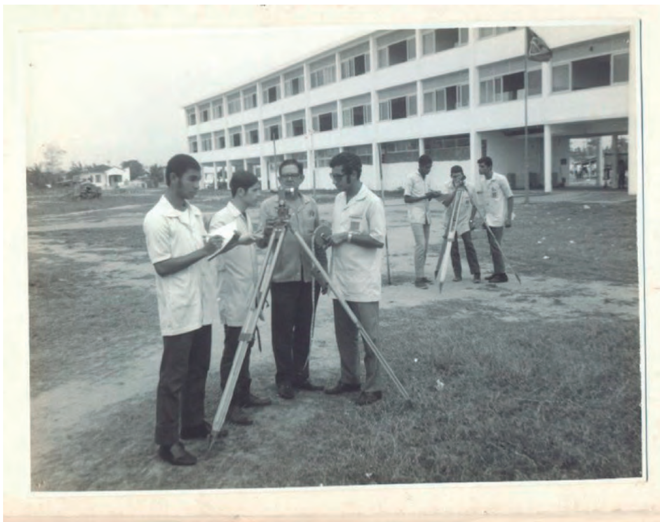
Novas instalações da Escola Técnica Federal de Campos Fonte: IFFluminense
