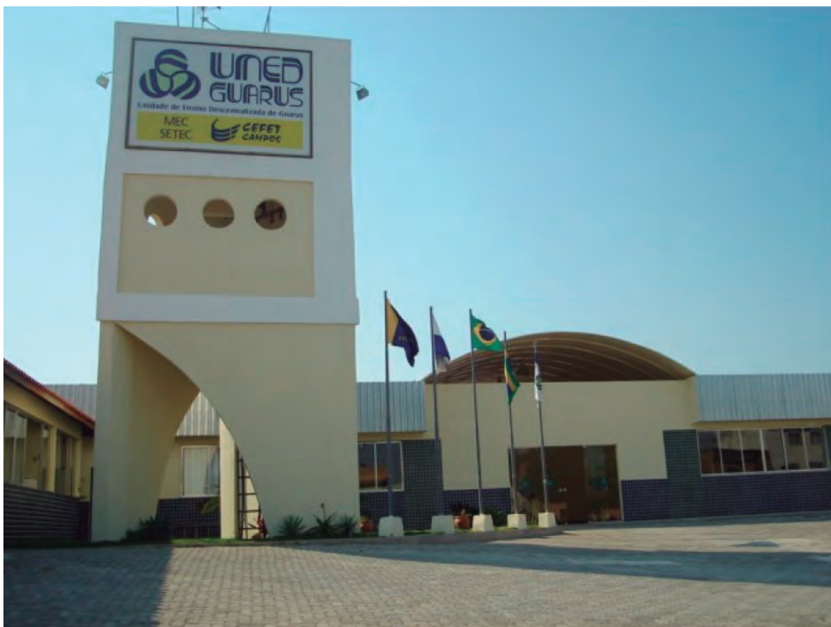
Fachada da Unidade de Ensino Descentralizada no distrito de Guarus Fonte: IFFluminense
