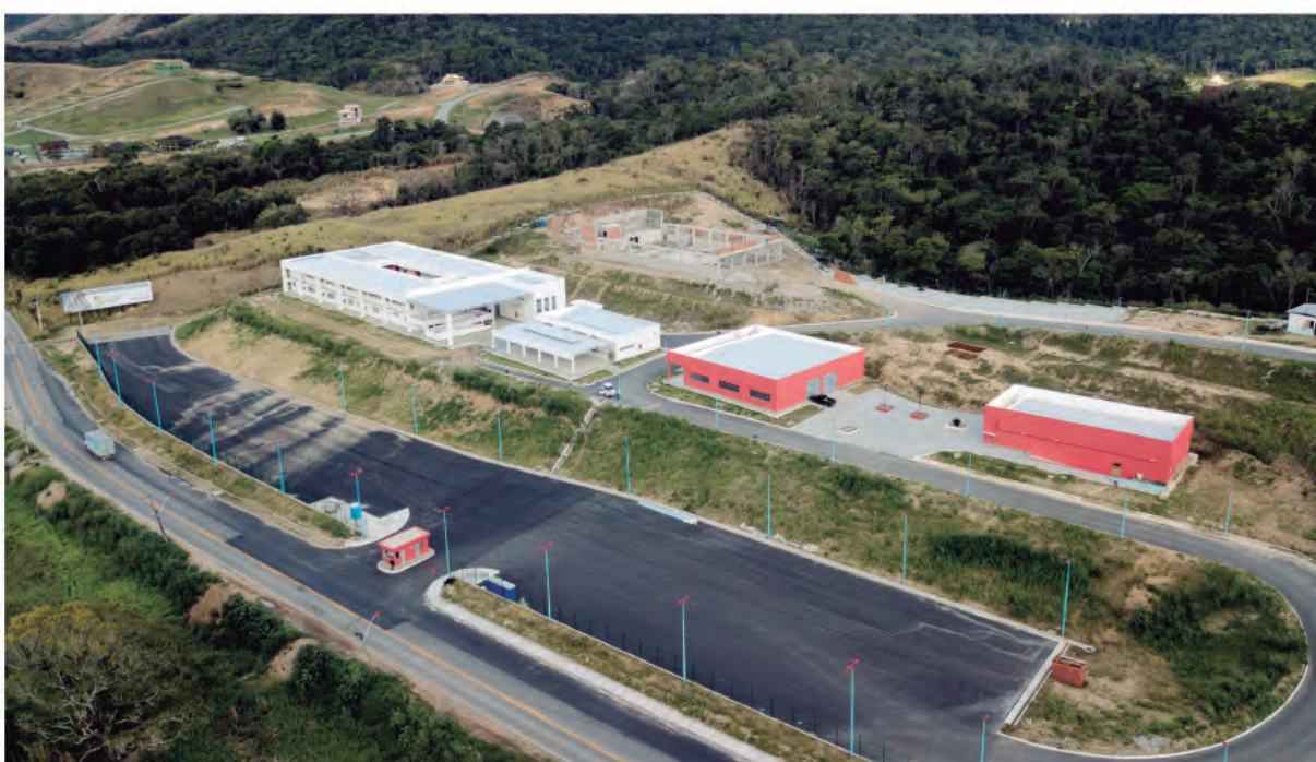
Imagem aérea das obras do Campus Maricá
