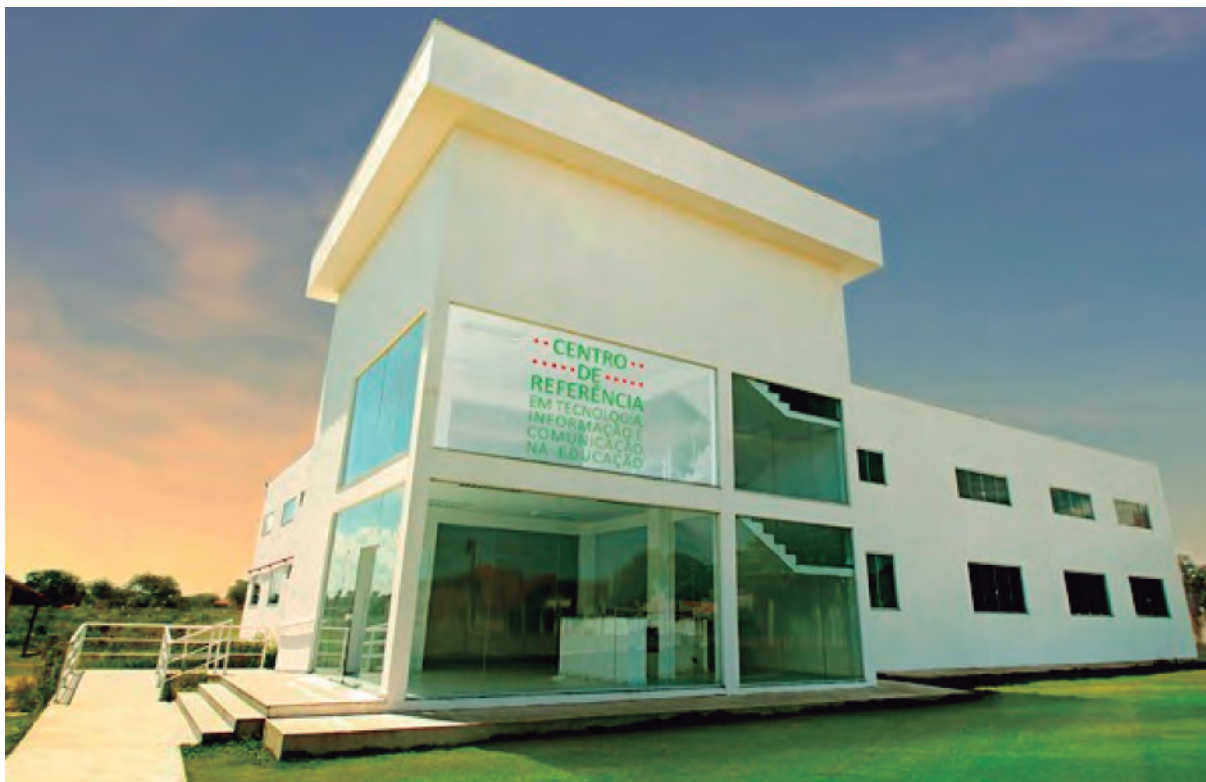
Fachada do Centro de Referência
