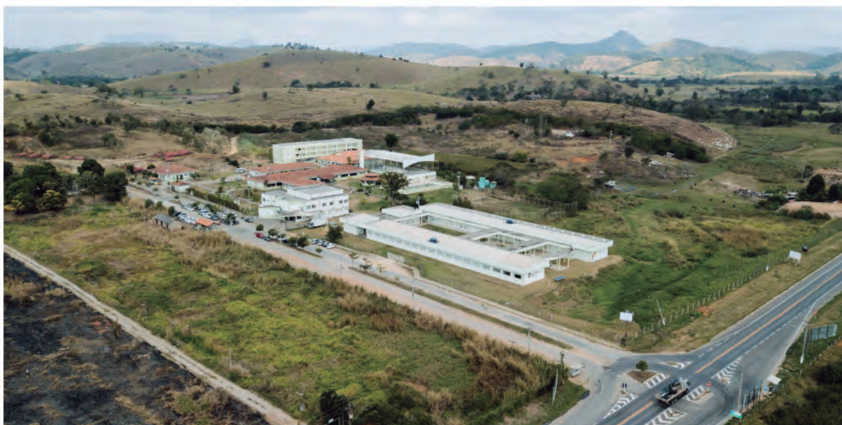
Imagem aérea do Campus Itaperuna Fonte: IFFluminense
